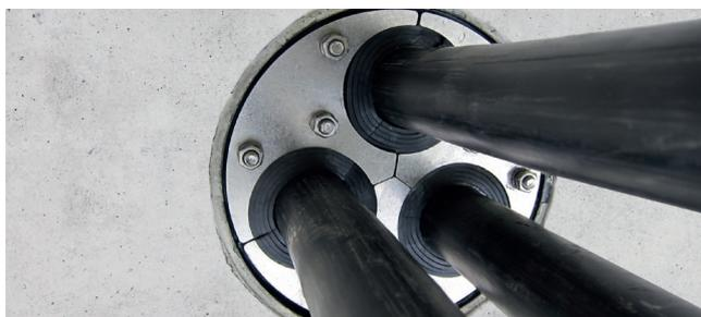
Segmentringtechnik im Einsatz: HRD 150-SG im Fundament einer Windenergieanlage
