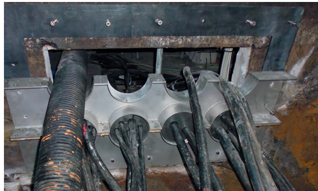
Felülettömítés falra ragasztott Sikaflex tömítőpasztával.
