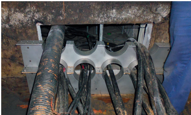
Az előszerelt peremlemez elhelyezése és a szerelési helyzetek jelölése a falátvezetés előtt.
