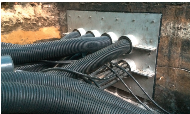
Készre szerelt peremlemez kábel- és csőátvezetéssel.
