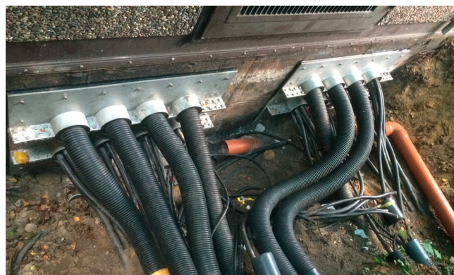
Új falátvezetés kábel- és védőcsőárokkel a visszatemetés előtt.
