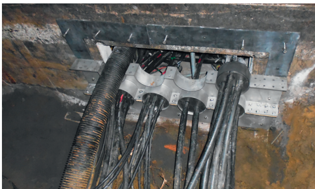
Peremlemez szerelése szakaszosan hosszú szárú dübellel és nemesacél csavarokkal.
